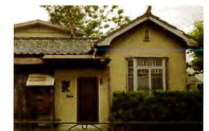
文化住宅 和洋折衷の住宅。ガス・電気・水道を備え、台所・浴室がつくられた。
